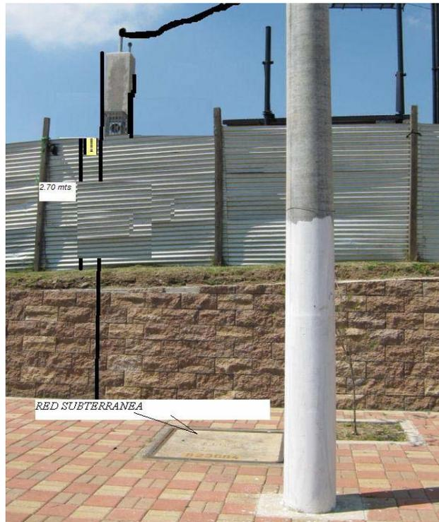
El diseño del sistema se basa en la premisa de que una falla en cualquier alimentador primario o transformador de no sea causa de interrupción por impacto de una rama o arbolado dentro de la ruta del circuito principal, dado que la carga está alimentada por el resto de los alimentadores primarios del sistema los cuales serán subterráneos.
