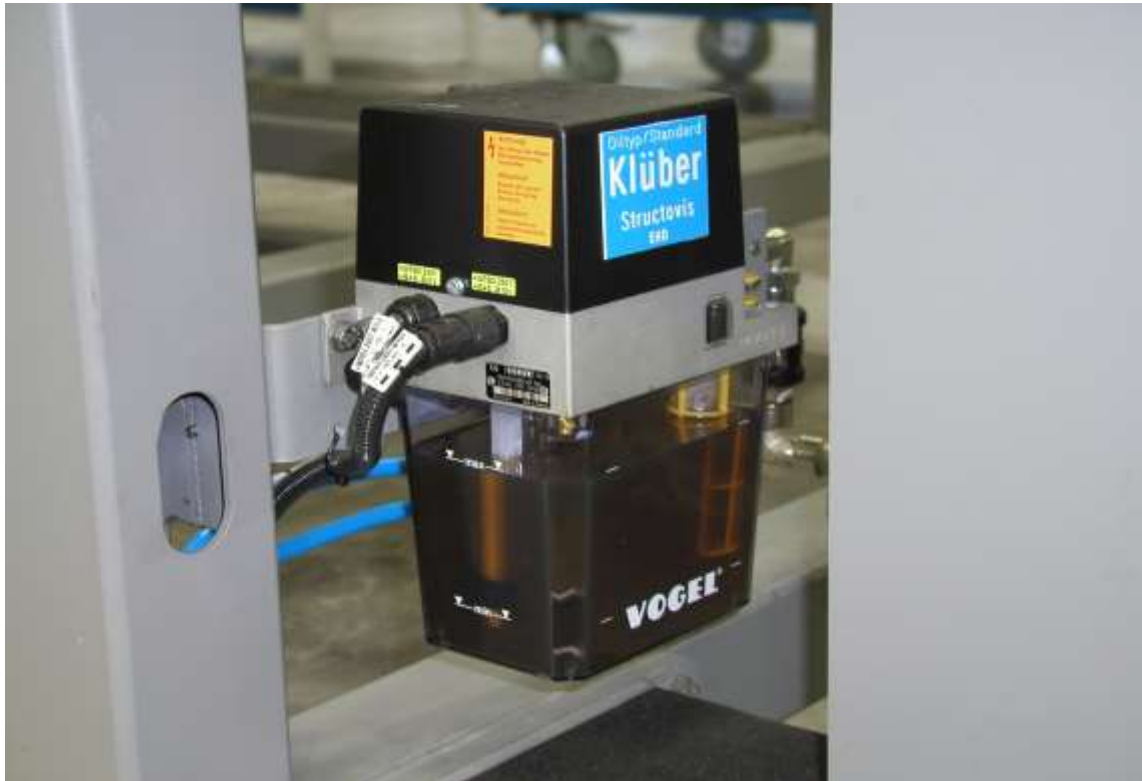
Figura 118. Unidad de lubricación centralizada
