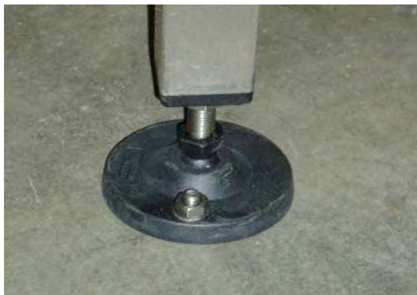
Figura 64. Anclaje de una de las patas
