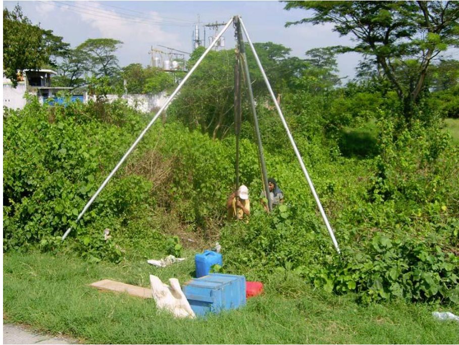
Ubicación de sondeo SPT No. 3, X : 20, Y : 0
