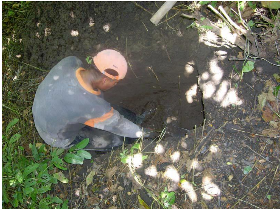
Calicata No. 3, X : 149.7, Y : 164.4
