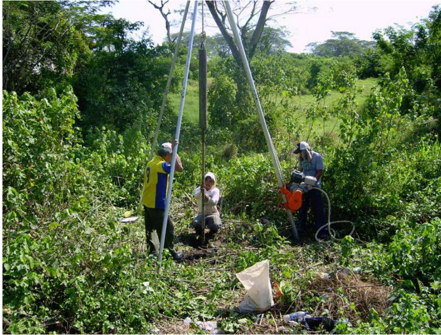
Ubicación de sondeo SPT No. 4, X : 25, Y : 0
