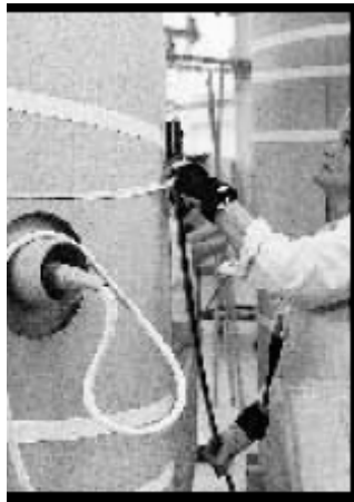
Construcción del sistema de aislamiento de barrera.
