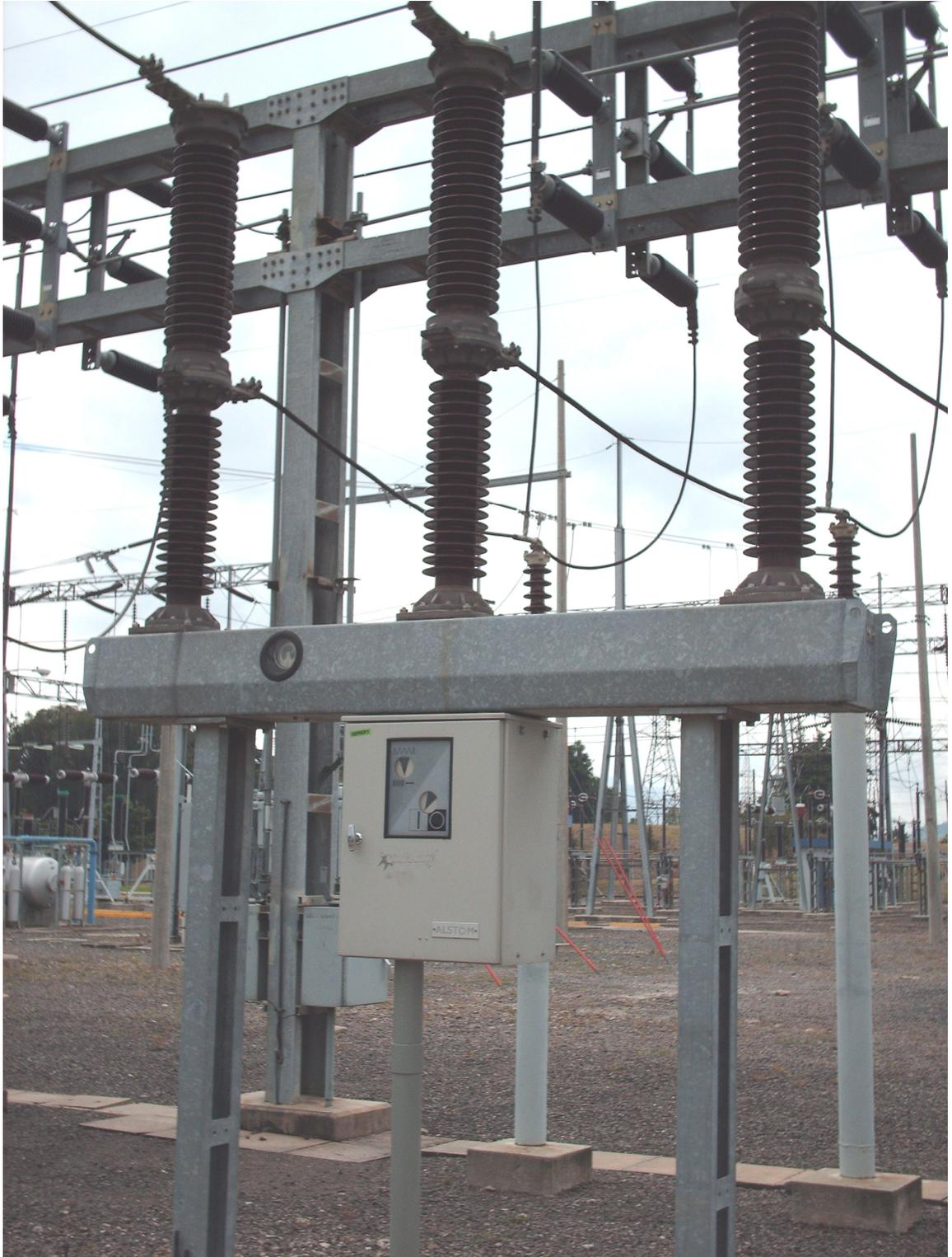
**Figura 5 transformadores combinados de medición, CT'S y PT'S de línea de carga**
