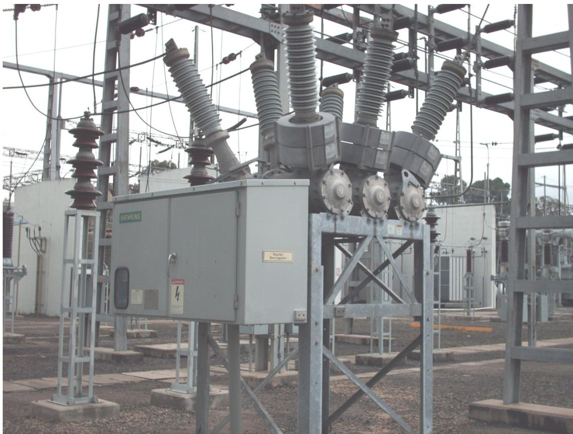
**Figura 10 puesta a tierra y pararrayos de banco No.1 de capacitores**
