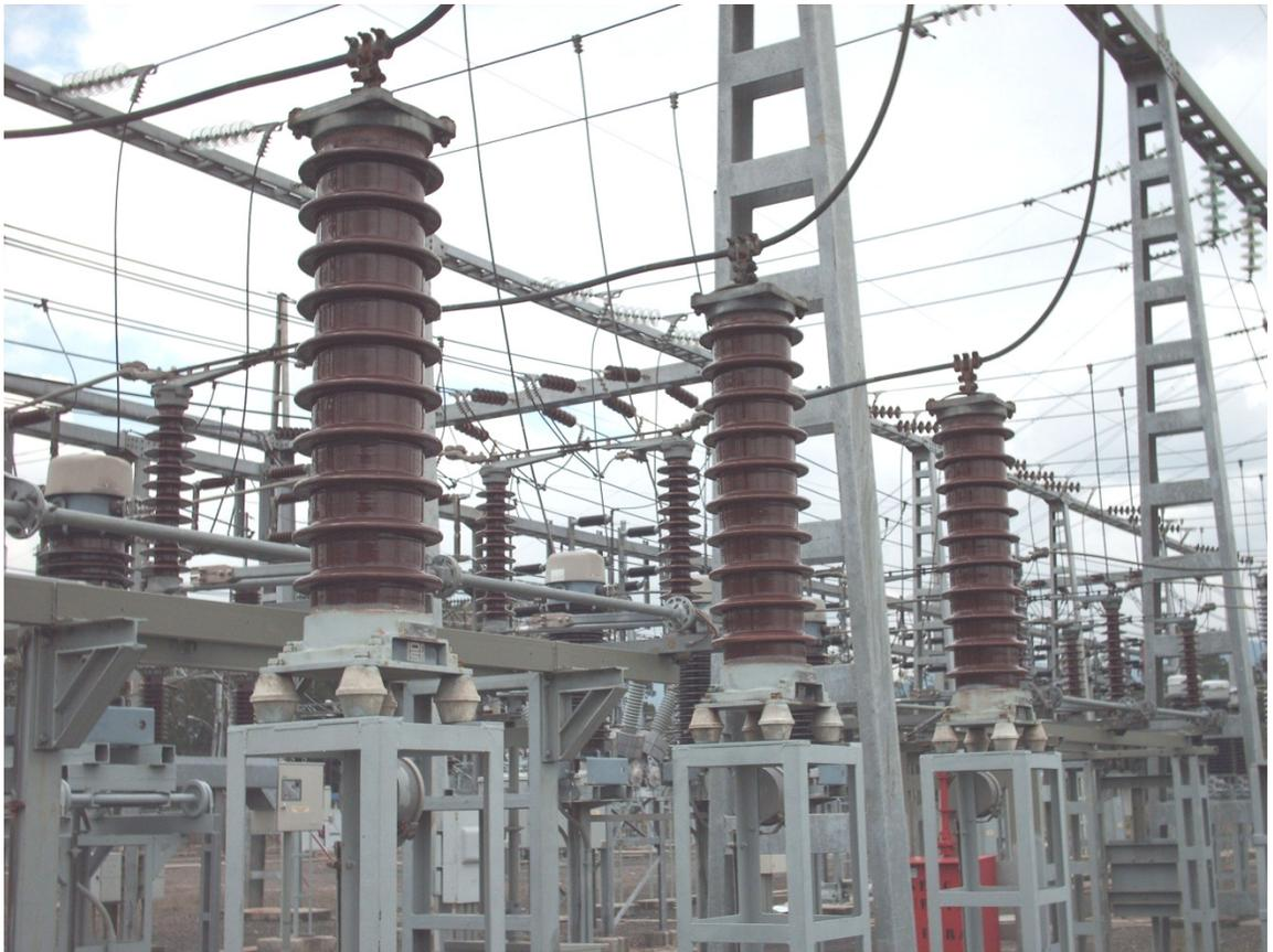
**Figura 8 banco No. 1 de capacitores de 10.8 KVAR**
