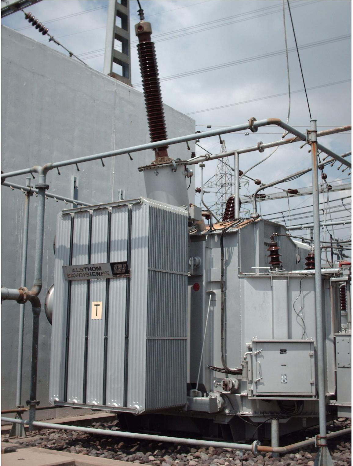
**Figura 3 transformador trifásico 70/100 MVA, 230/69 KV**
