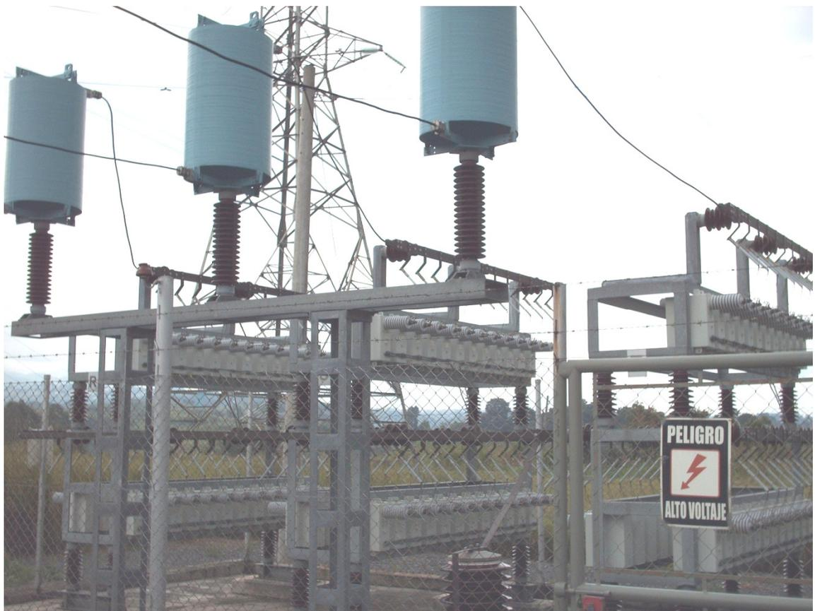
**Figura 9 interruptor de potencia de SF6 de banco No. 1 de capacitores**
