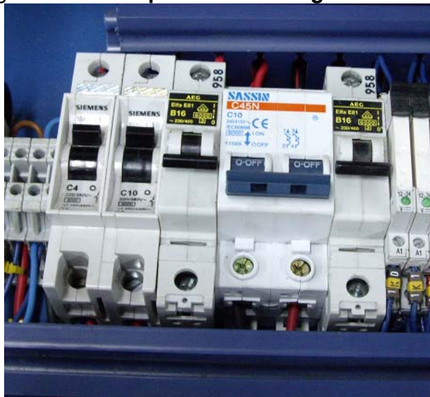
Figura 87. Interruptores termomagnéticos
