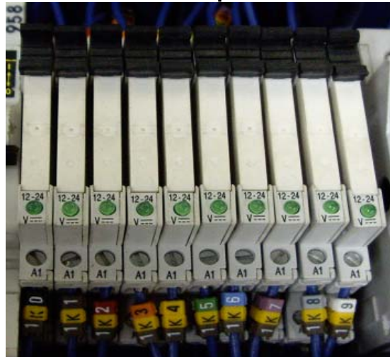
Figura 88. Relés de interposición/aislamiento
