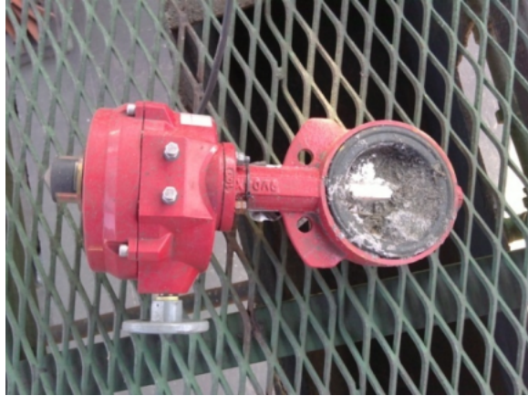
Figura 20. Válvula tipo mariposa para el fondo de los decantadores
