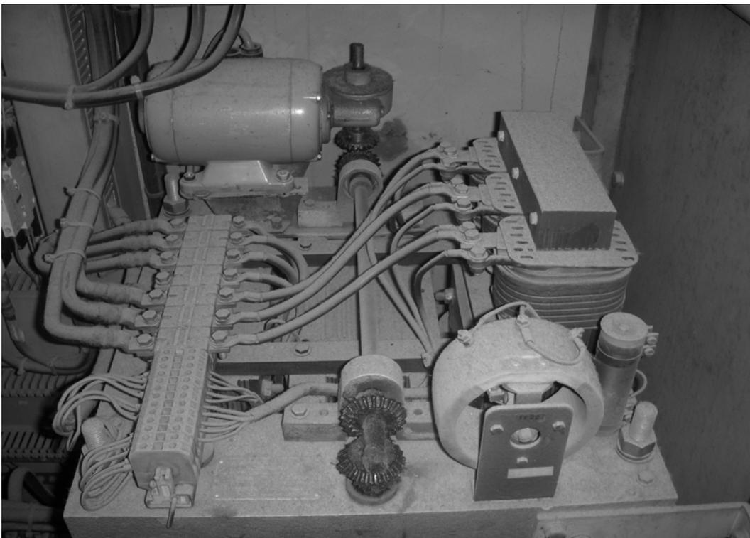
Figura 12. Parte superior del autotransformador donde va montado el sistema motriz del motor 1m21.
