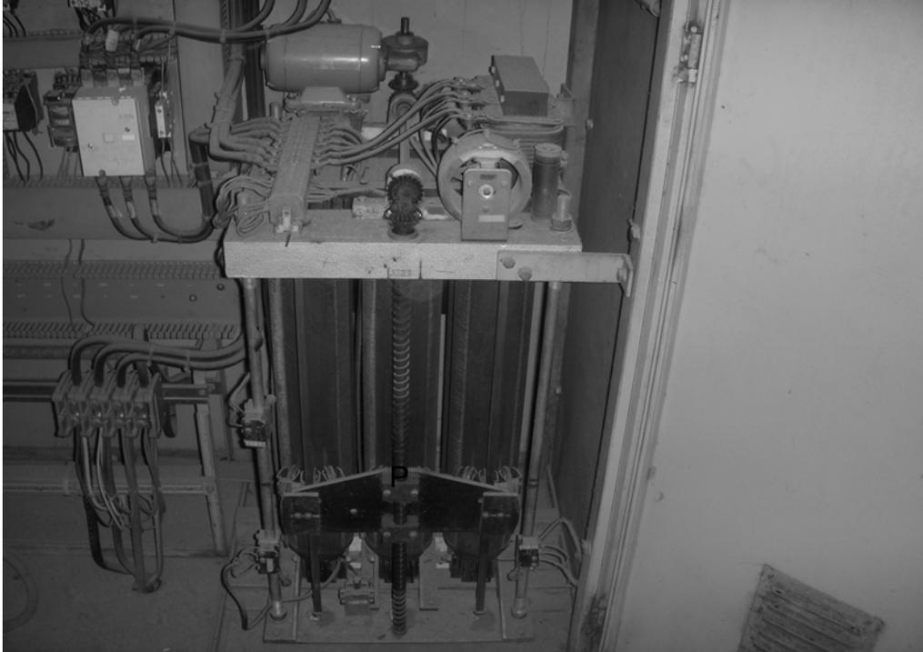
Figura 13. Vista donde se observa como se deslizan los carbones esféricos sobre los devanados del autotransformador.
