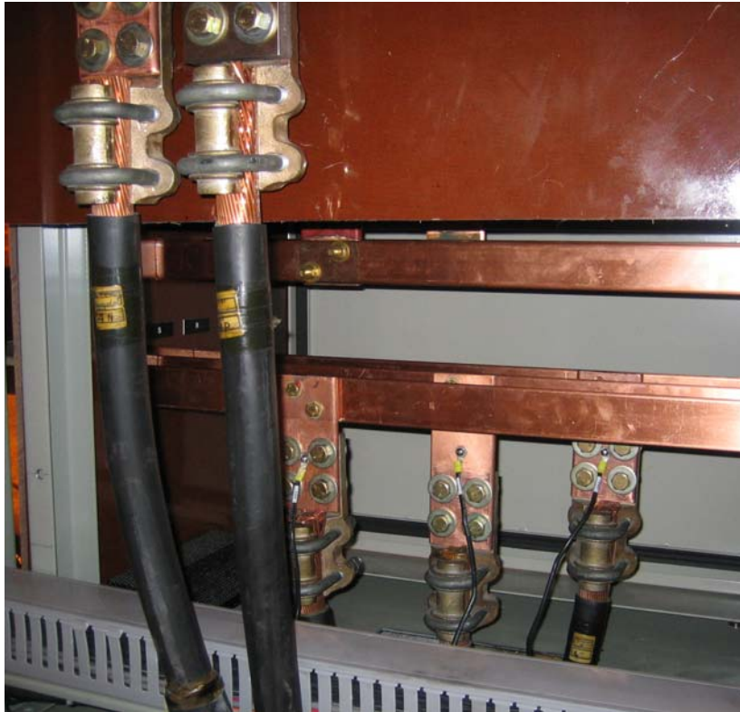
Figura 32. Conexión corriente alterna trifásica transformador de excitación-RAV y conexión de salida de corriente directa RAV-generador síncrono
