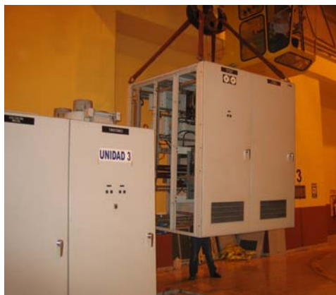
Figura 25. Desmontaje de AVR MEC-3400-W
