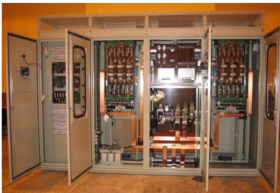
Figura 30. RAV 1111 2P 550K/220 listo para acoplamiento al generador síncrono
