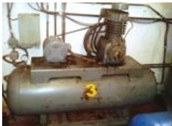
Figura 10. Compresor horizontal # 3
