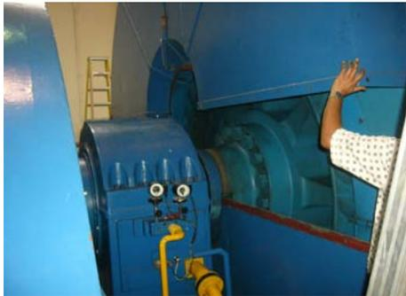
**Figura 7 Retiro de tolva de turbina Unidad 3**
