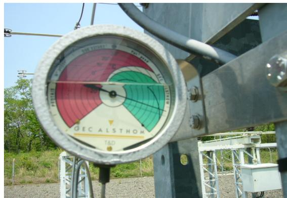
Por medio del manómetro podemos ejercer la vigilancia del SF6 además podemos diagnosticar la necesidad o no de inyección de SF6 por medio del densímetro, la cual a excepción de que este se encuentre deteriorado se realiza automáticamente.
