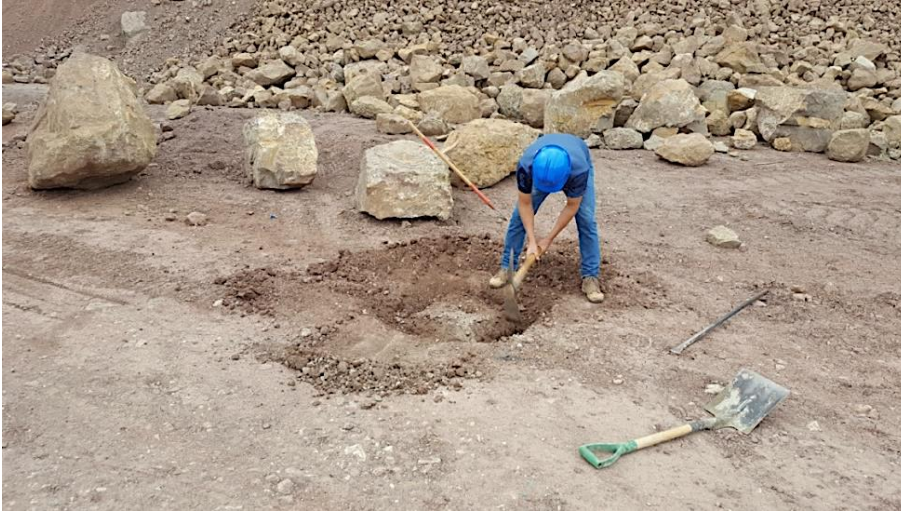
Figura 11. Toma de muestras inalteradas, km.78+700 CA-9
