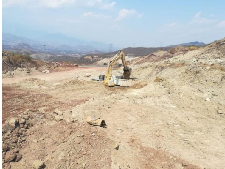
Figura 41. Limpieza y remoción del deslizamiento
