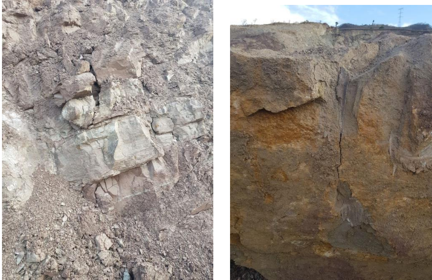
Figura 9. Muestras de roca aparentemente meteorizadas, deslizamiento km. 78+600 al 78+800 CA-9 Norte
