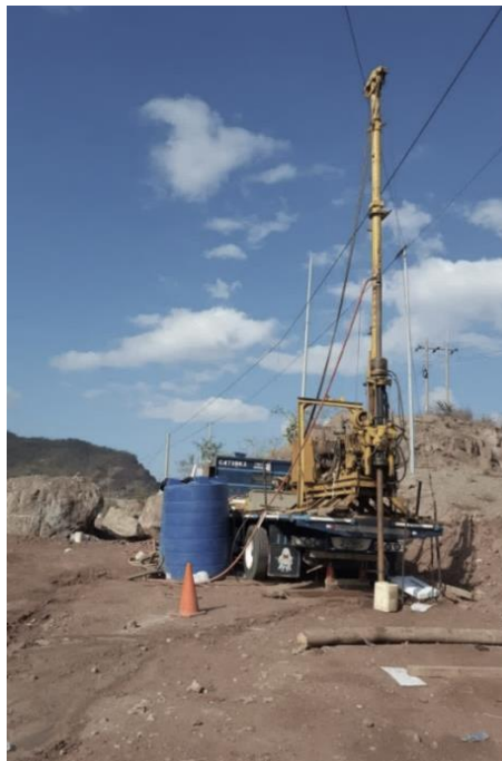
Figura 14. Maquinaria con tubería de recuperación de núcleo, sondeo de penetración estándar, SPT km.78+800
