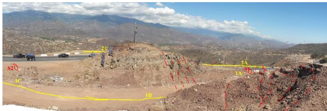
Figura 23. Panorama de los escarpes secundarios y de fracturas de expansión general (vista posterior)
