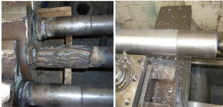
Figura 26. Reparación de paletas o álabes directrices
