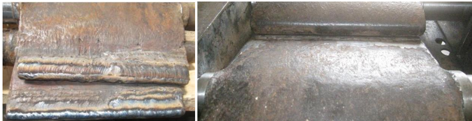
Figura 25. Reparación de paletas del gobernador
