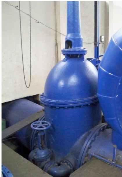
Figura 18. Válvula de compuerta
