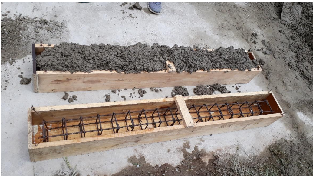
Figura 23. Elaboración del elemento viga
