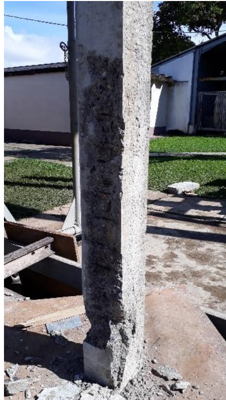
Figura 47. Ensayo a compresión de elemento columna con azúcar como aditivo retardante del hormigón
