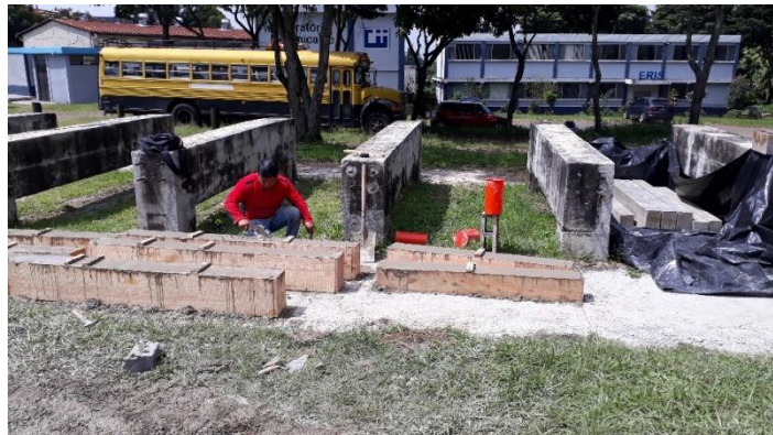
Figura 45. Armado de elementos columnas con azúcar como aditivo retardante
