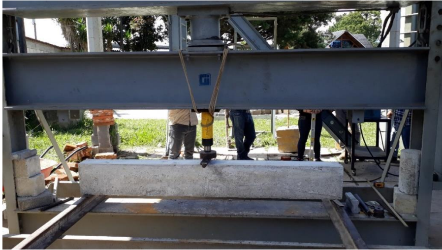
Figura 37. Colocación de elemento viga para ensayo a flexión
