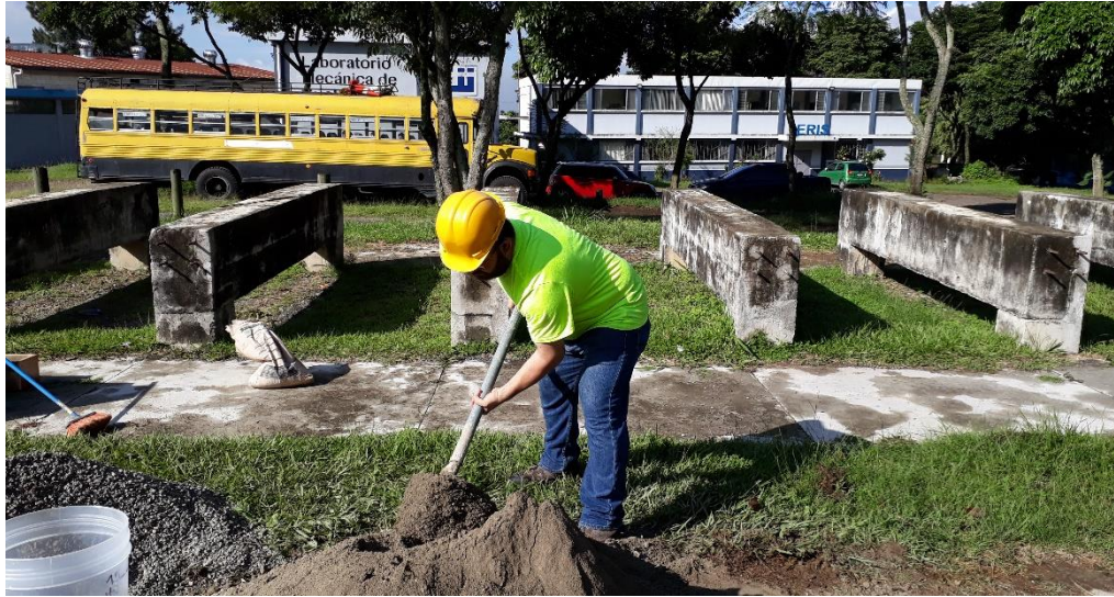
Figura 22. Fundición del hormigón para elemento viga
