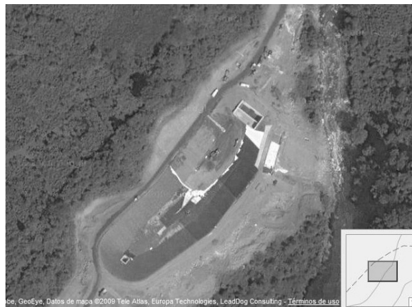
Figura 32. Embalse hidroeléctrica Monte Cristo
