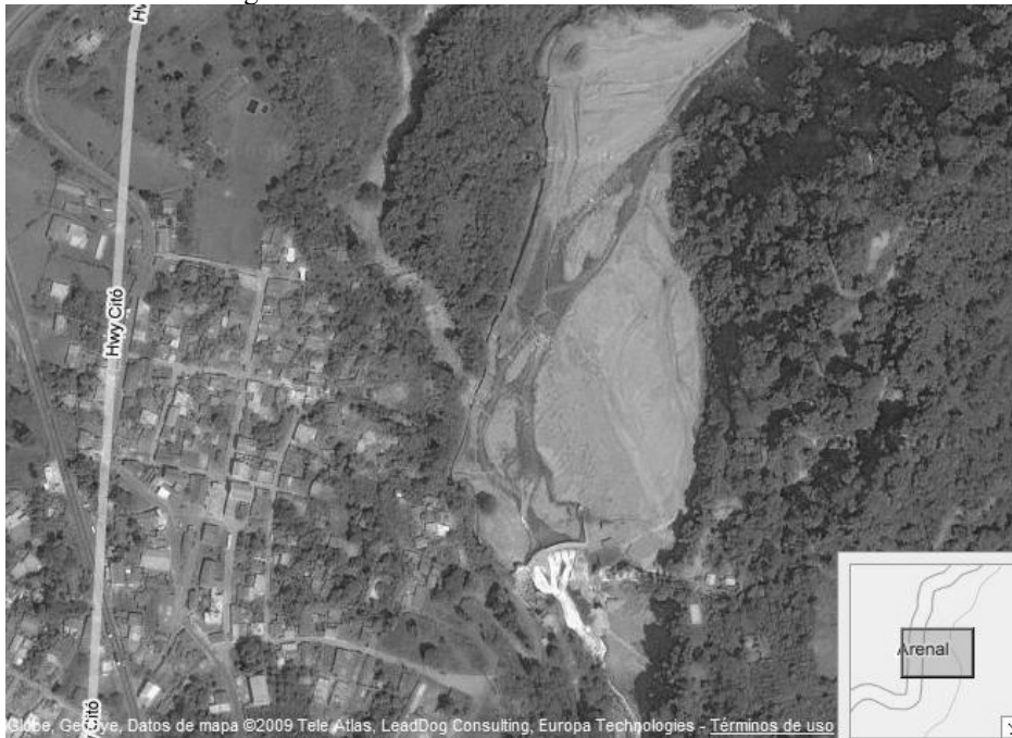
Figura 30. Embalse hidroeléctrica Santa María
