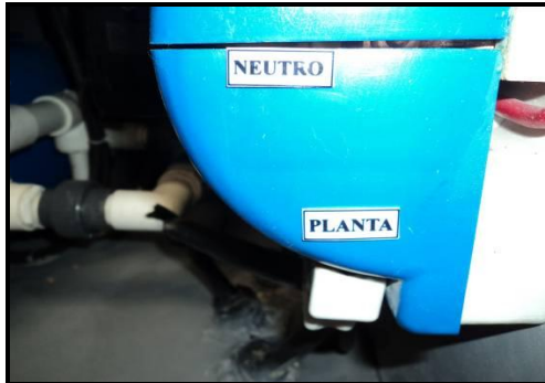
Figura 13. Transferencia manual (planta)
