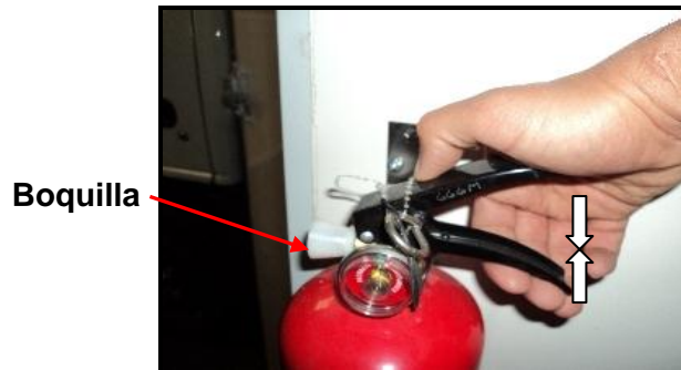
Figura 40. Uso de extinguidor
