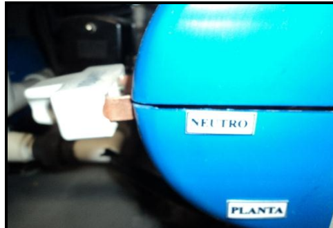
Figura 35. Transferencia manual
