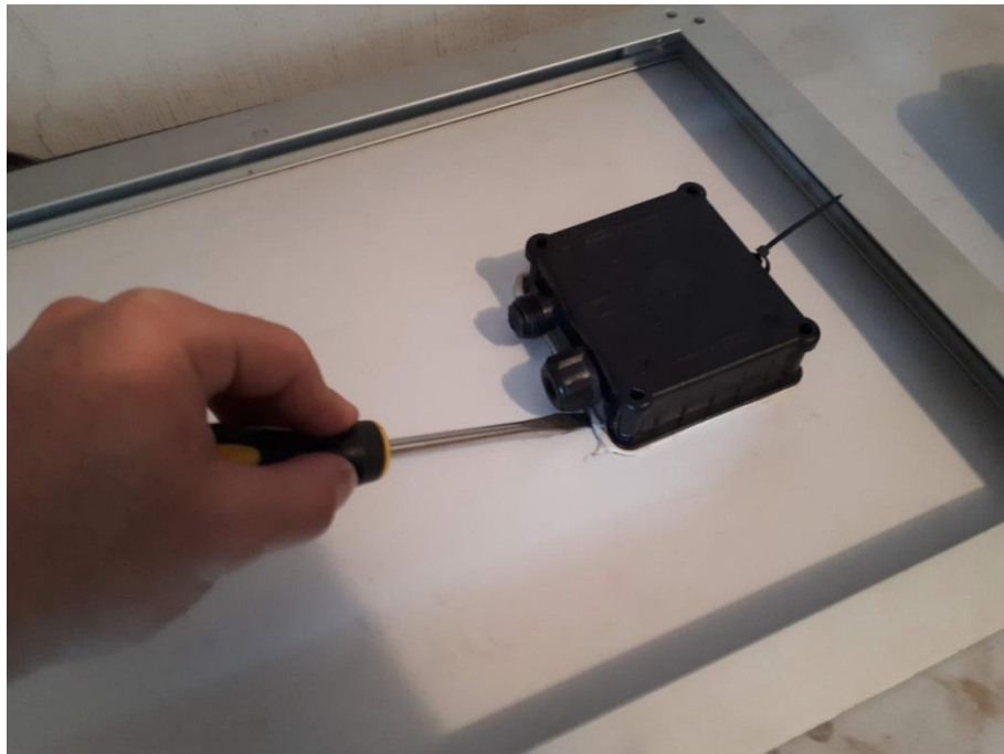
Figura 8. Desmantelamiento de la caja de conexiones
