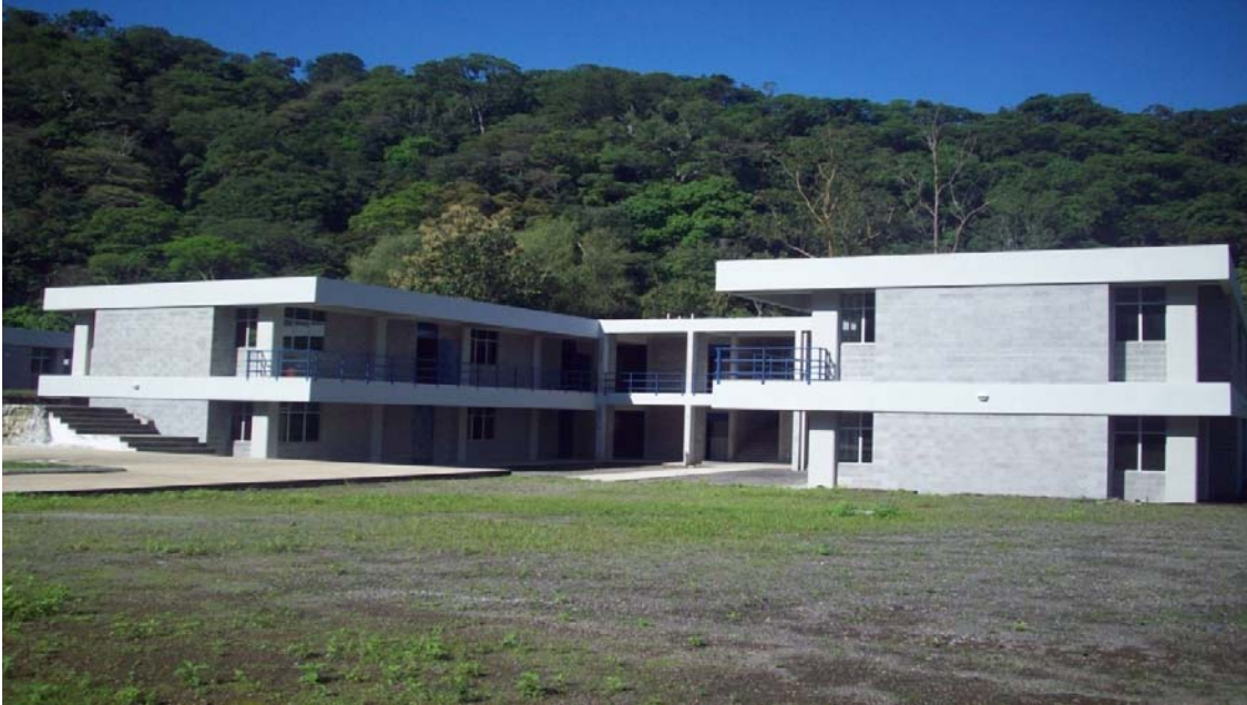
Vista del módulo de aulas puras.
