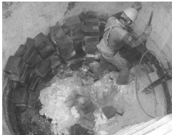
Figura 30. Demolición del piso de ladrillos de una olla
