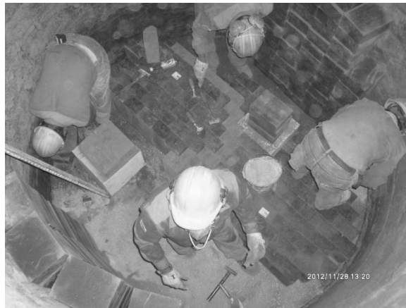
Figura 32. Armado del piso de ladrillos de una olla
