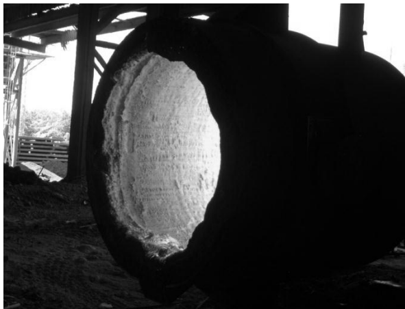
Figura 23. Desgaste en línea de escoria de una olla
