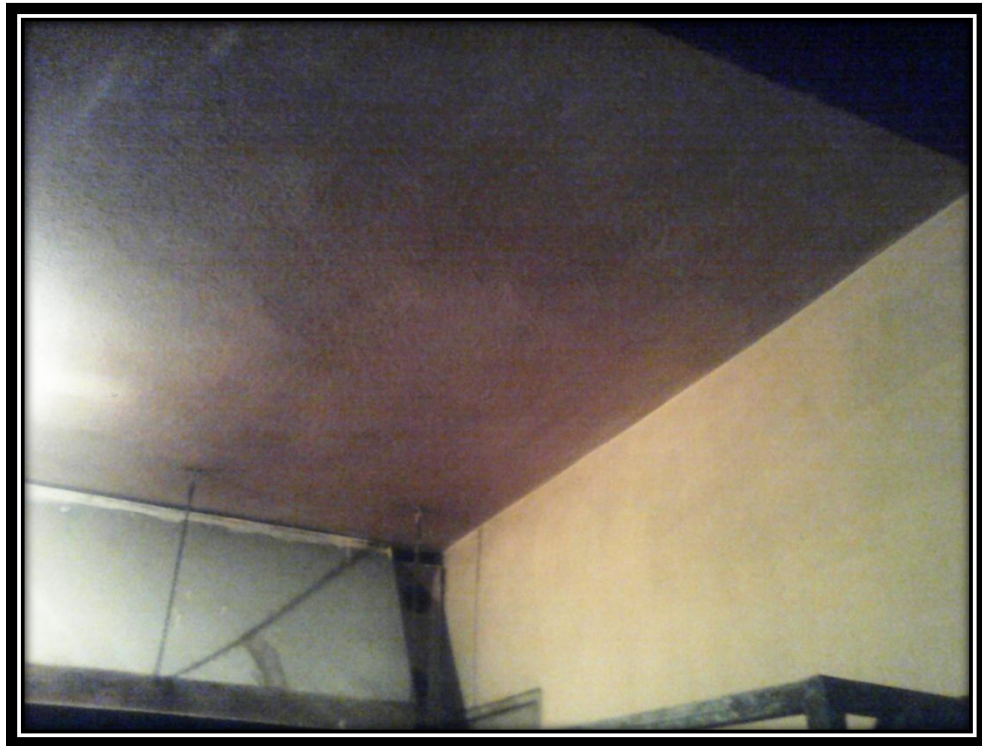
Figura 11. Fotografía de techos
