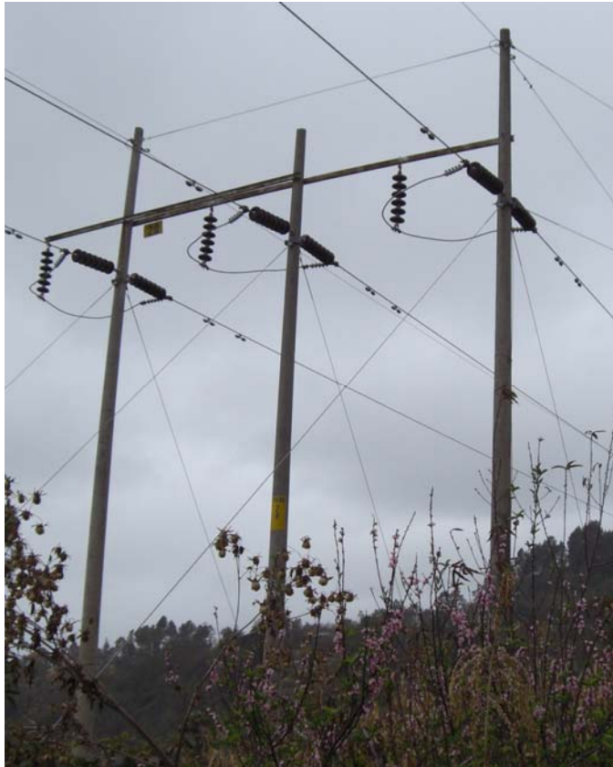
Figura 27. Ilustración de estructura tipo IV
