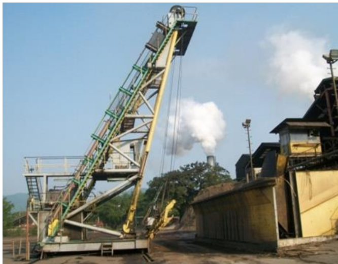
Figura 17. Grúa principal de descarga de caña
