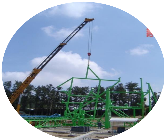
Figura 2. Colocación de grupo estructural
