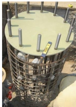
Figura 55. Colocación de platina
