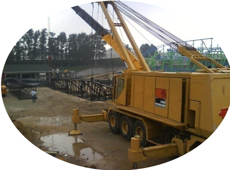
Figura 3. Armar Grúa de 200 toneladas
