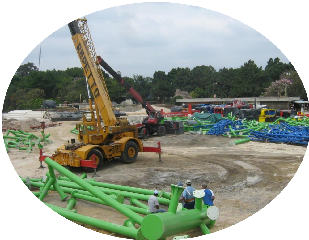
Figura 13. Patio de acopio
