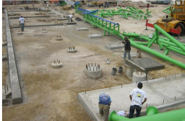
Figura 54. Cimientos con pernos fundidos
