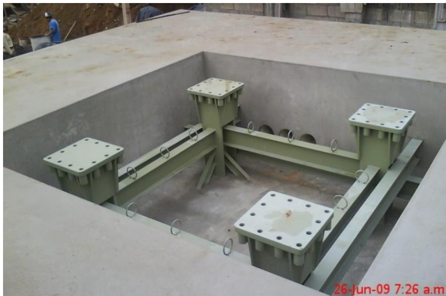
Figura 57. Base estructural embebida en los cimientos
