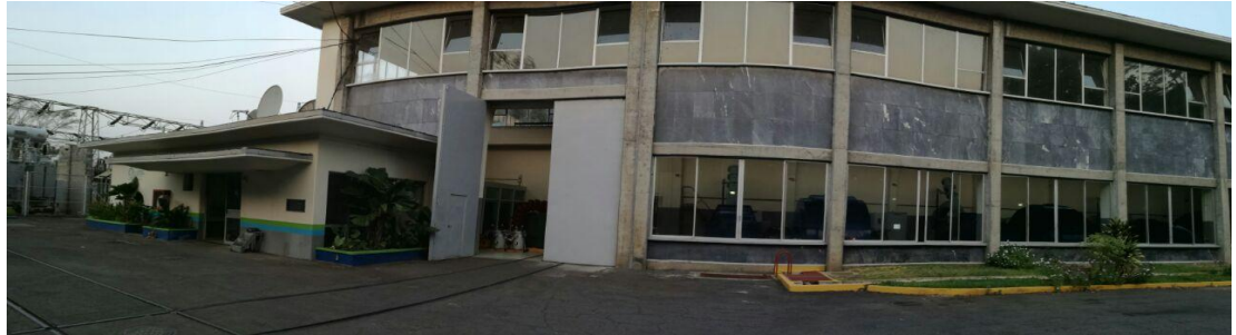
Figura 2. Casa de máquinas de Jurún Marinalá
