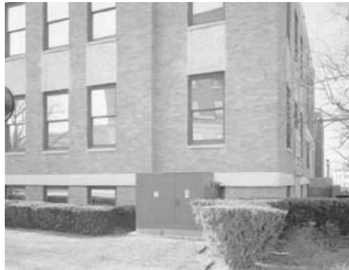
Figura 9. Vista de una posible bóveda con transformadores que serán refrigerados con aceite dieléctrico de alto punto de inflamabilidad
