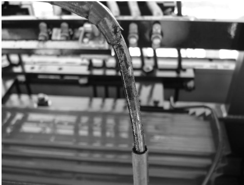
Figura 12. Restos de papel kraft impregnados en el cobre
