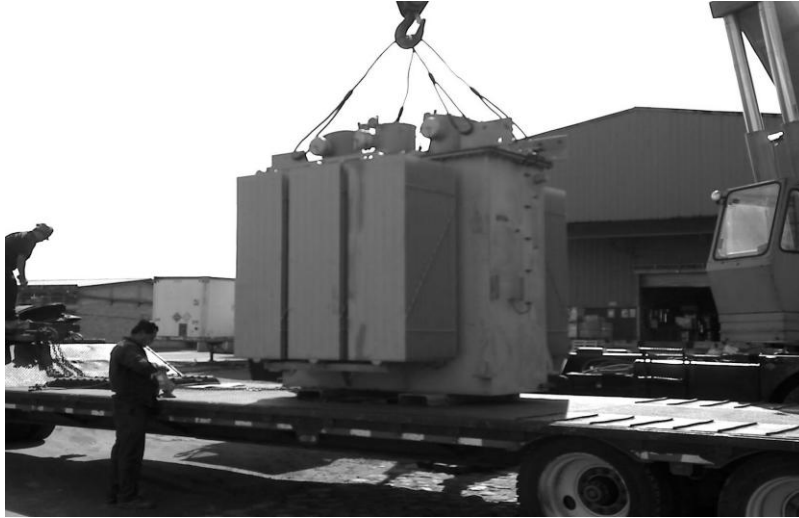
Figura 21. Traslado de transformador hacia la subestación
