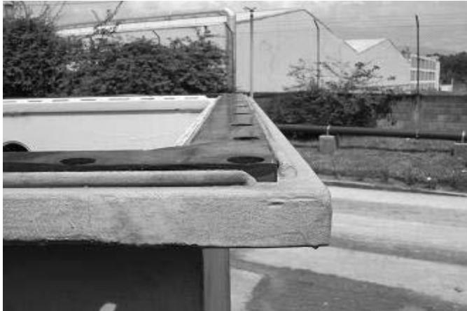
Figura 19. Instalación de nuevo empaque con material nitrilo-neopreno
