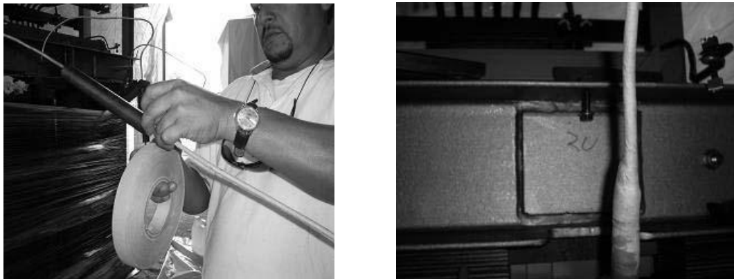
Figura 13. Aplicación de papel kraft en la barra de cobre
