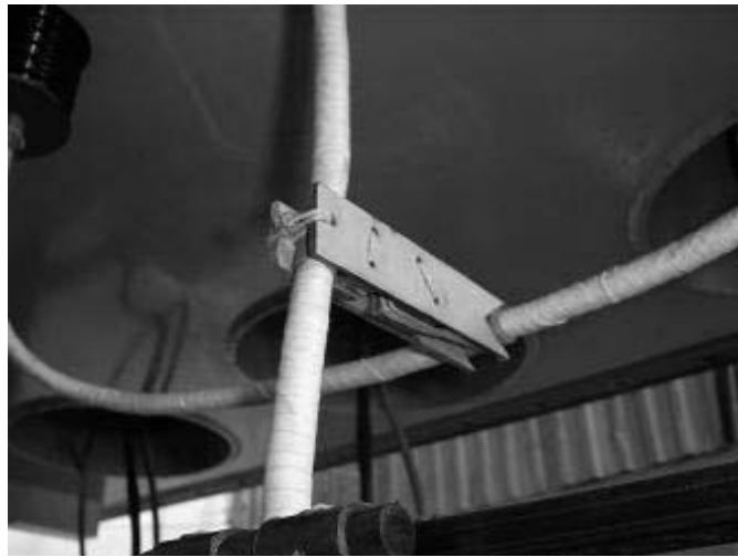
Figura 15. Instalación de horquilla nueva
