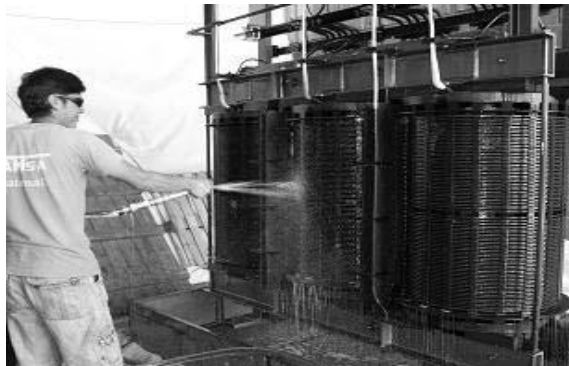
Figura 17. Limpieza de bobinas con aceite dieléctrico
