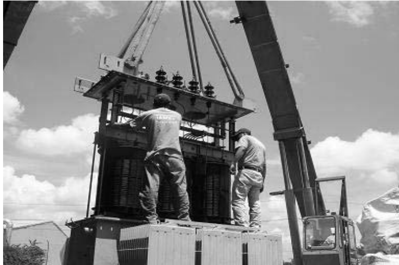
Figura 20. Colocación de núcleo ya reparado en su cuba
