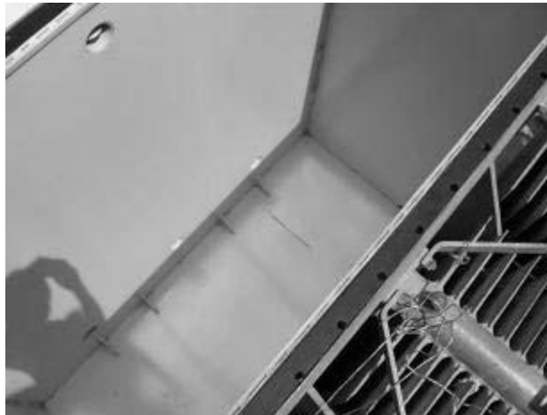
Figura 18. Limpieza de paredes y fondo de cuba
