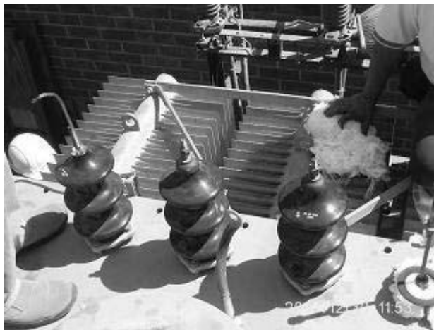
Figura 9. Instalación de nuevo pines en el lado de baja tensión
