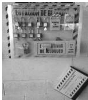
Figura 26. Estación de bloqueo de equipos en taller automotriz LP
