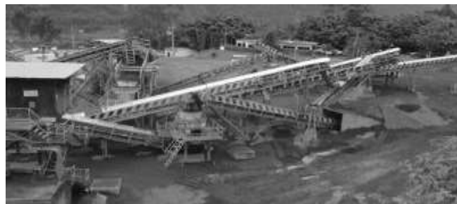
Figura 44. Proceso de trituración terciario planta PPO
