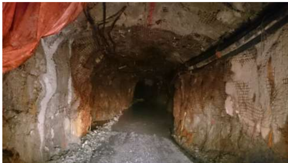
Figura 28. Condiciones de túnel sin implementar sistema de pozos
