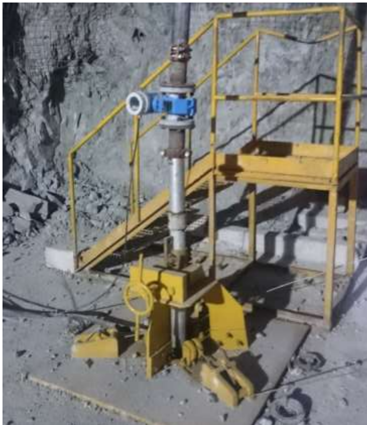
Figura 23. Instalación final de pozo
