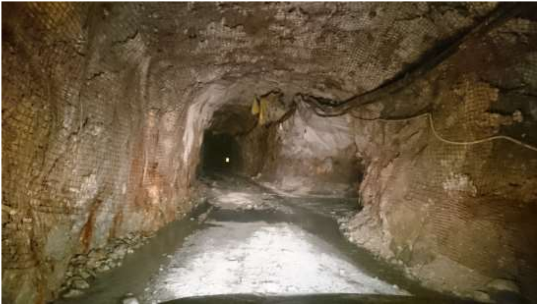
Figura 29. Condiciones de túnel implementado el sistema de pozos
