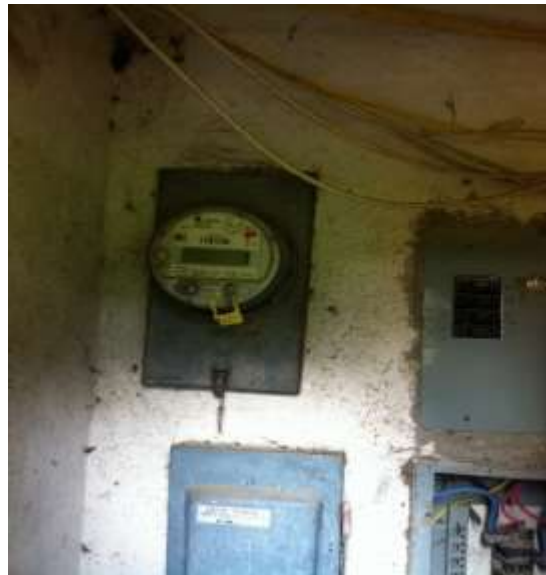
Figura 15. Acometida eléctrica Granja Experimental Facultad de Medicina y Zootecnia
