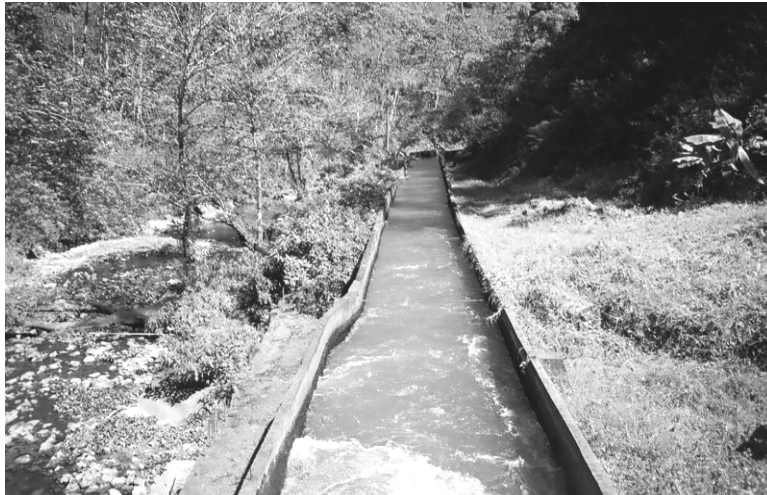
Figura 5. Canal de conducción de flujo
