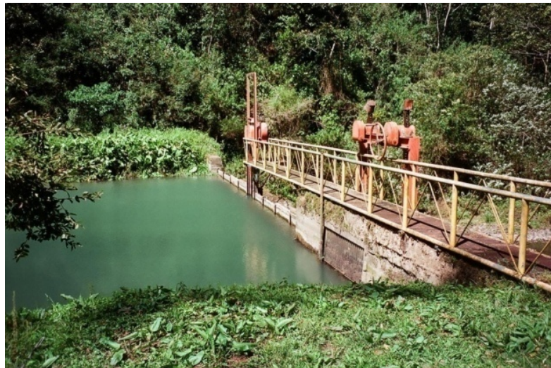
Figura 20. Presa de la Planta Hidroeléctrica Chichaic
