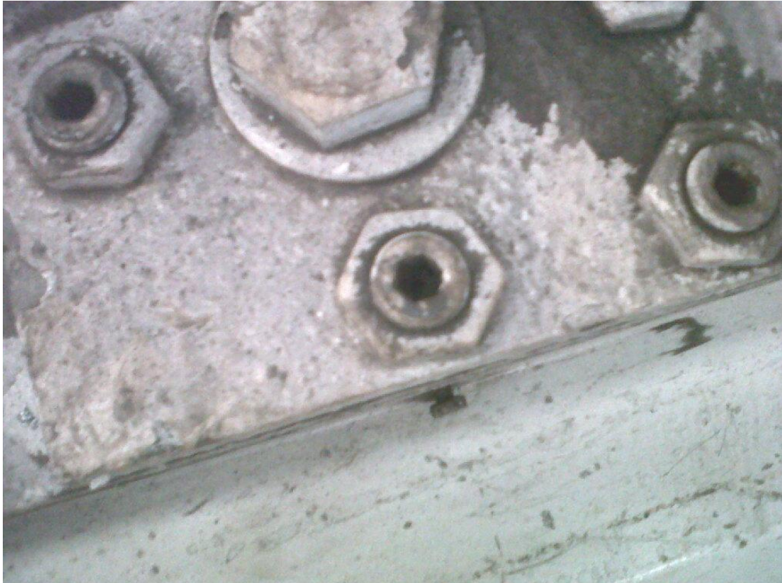
Figura 22. Tornillos para llave hexagonal y para llave de corona o cola
