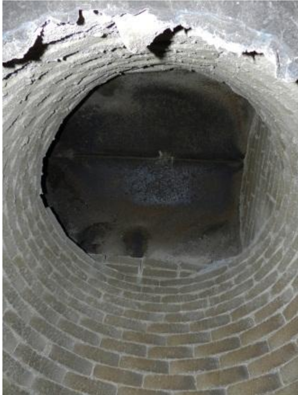
Figura 5. Cámara de generación activa
