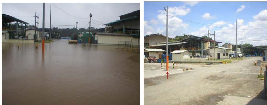
Figura 19: Instalaciones antes y después de la inundación
