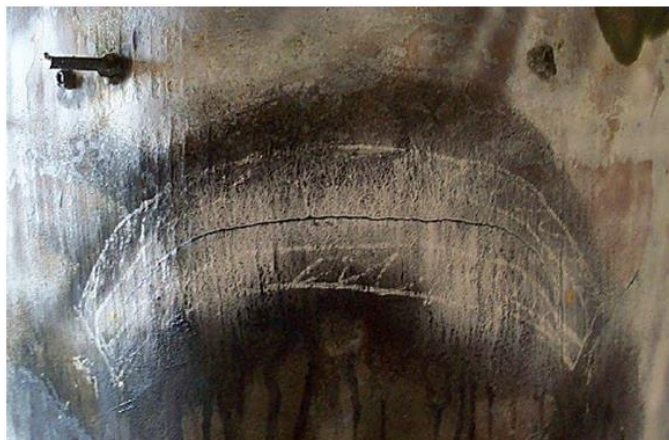
Figura 21. Revelación de la misma fisura por partículas magnéticas
