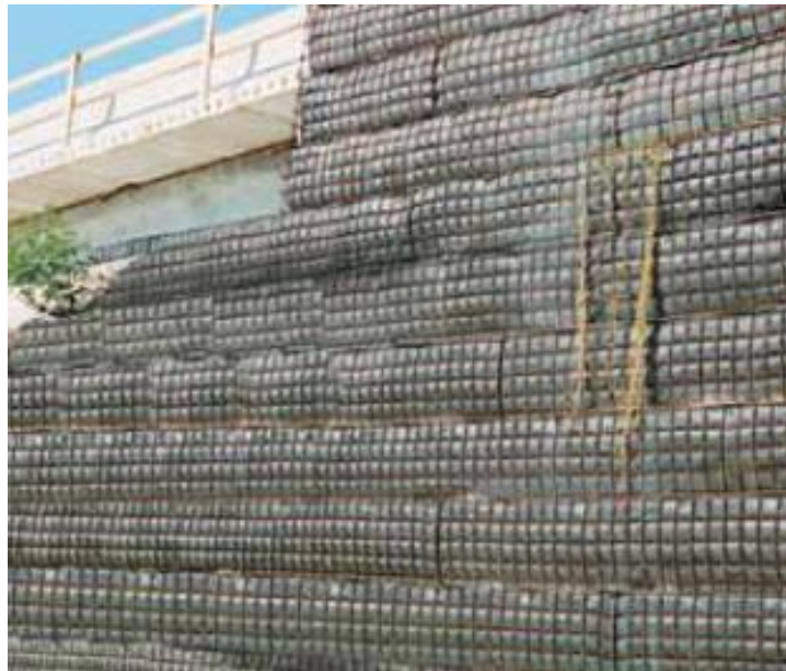
Figura 4. Fachada de geosintético
