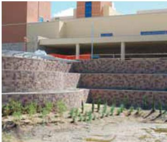
Figura 14. Muro de contención St. Anthony's Hospital - Denver, Colorado
