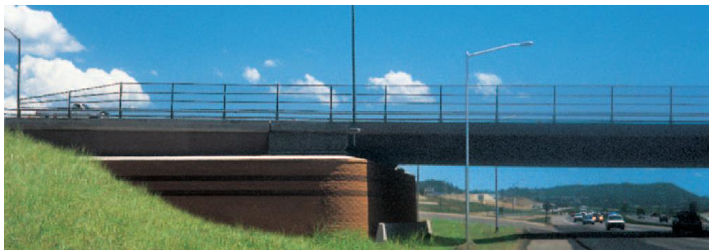
Figura 13. Estribo de puente I-25 Castle Rock, Colorado
