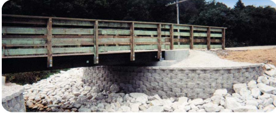
Figura 3. Fachada de bloque de concreto - segmentado
