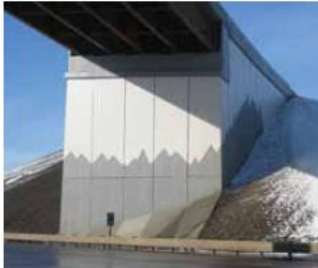
Figura 5. Fachada de paneles de concreto de altura completa
