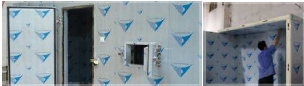
Figura 36. Forma de aislamiento con paneles de poliuretano
