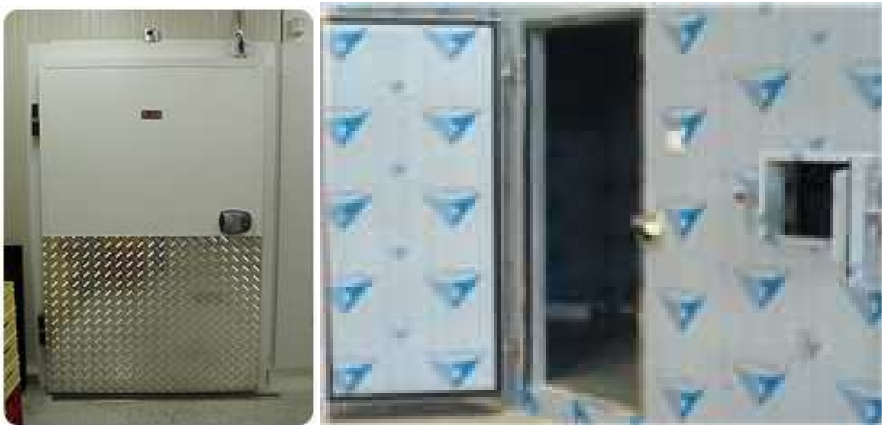
Figura 39. Puerta de cuarto frío con apertura exterior suave e interior de seguridad
