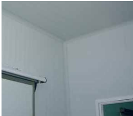
Figura 63. Paneles sellados con silicona
