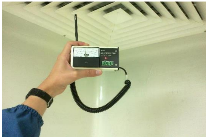
Figura 90. Medición en la rejilla de suministro (I)
