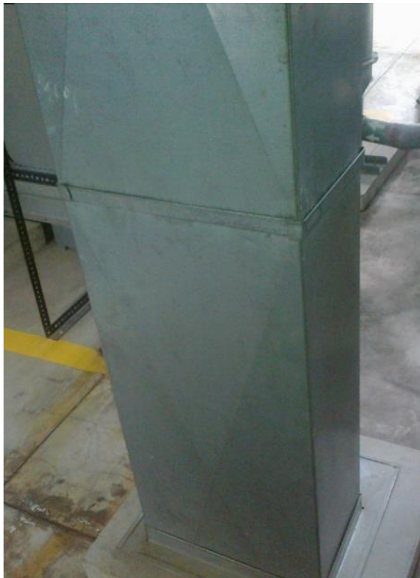
Figura 32. Uniones de ductos
