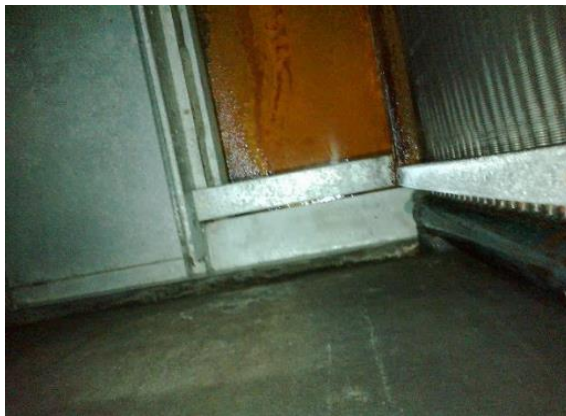
Figura 122. Bandejas de agua con óxido
