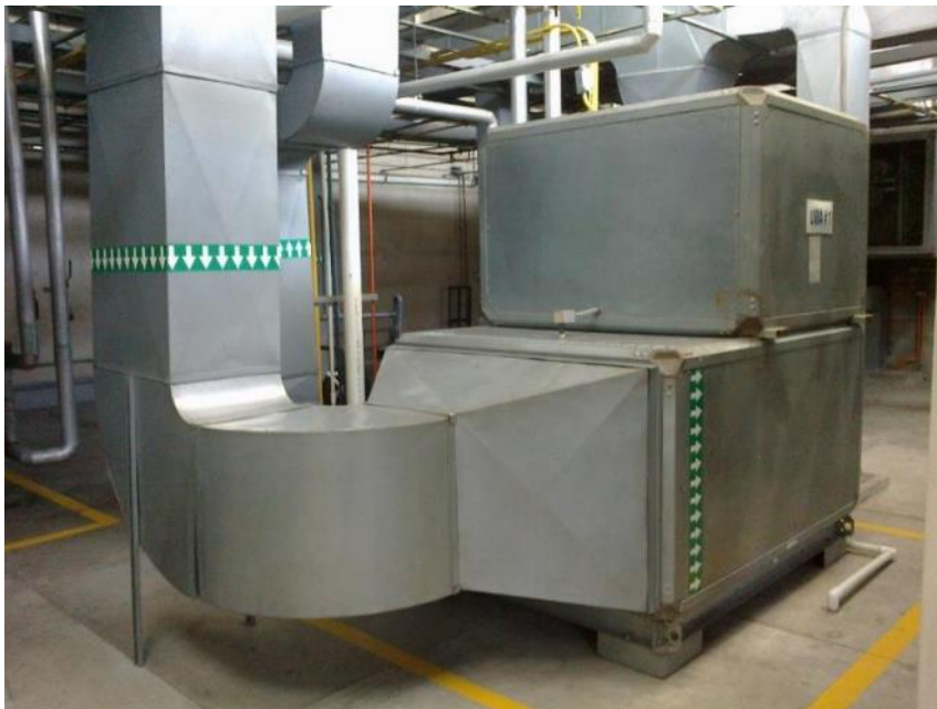
Figura 138. Unidad Manejadora de Aire por fuera (II)
