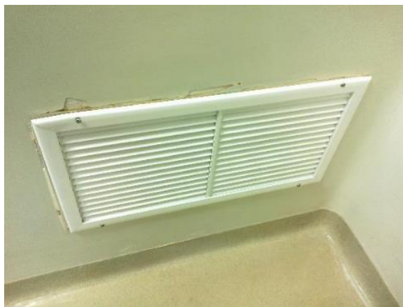
Figura 116. Rejilla de extracción
