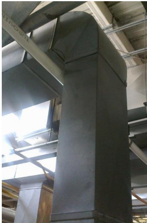
Figura 33. Uniones en secciones curvas
