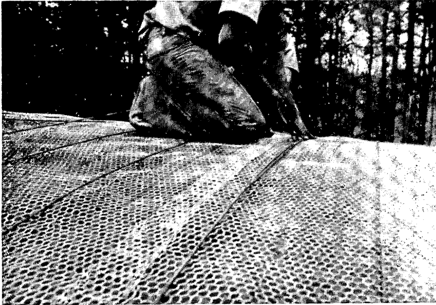
FOTO No. 9 COLOCACION DE MALLA DE REFUERZO Y VARILLAS
