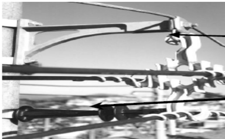
Figura 21. Piquete con sostén de brazo anti balanceó
