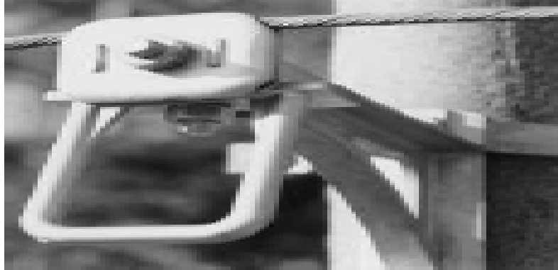
Figura 22. Piquete con sostén de brazo anti balanceo, vista frontal
