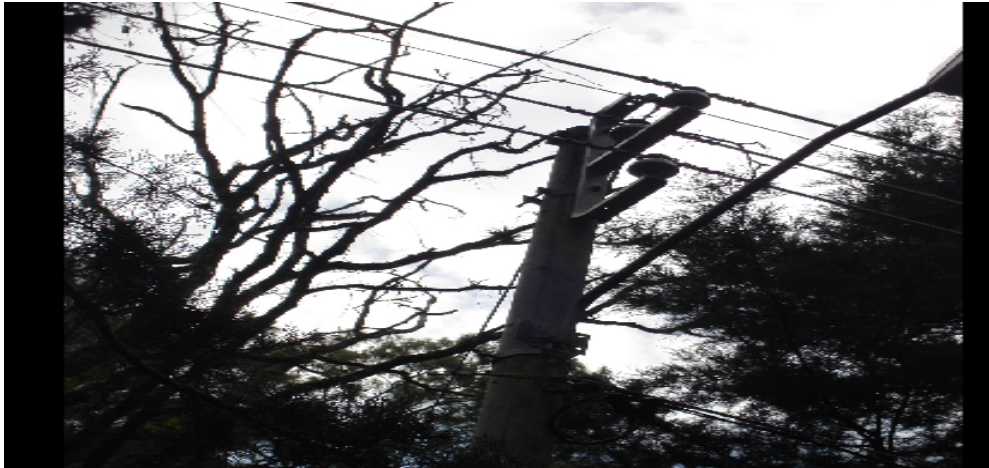
Figura 35. La desventaja de utilizar conductor desnudo, representa índices de deforestación
