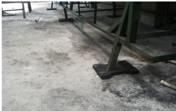
Figura 31. Vista de cimentación del suelo
