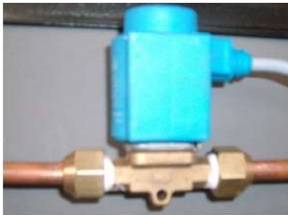
Figura 49. Instalación válvula solenoide
