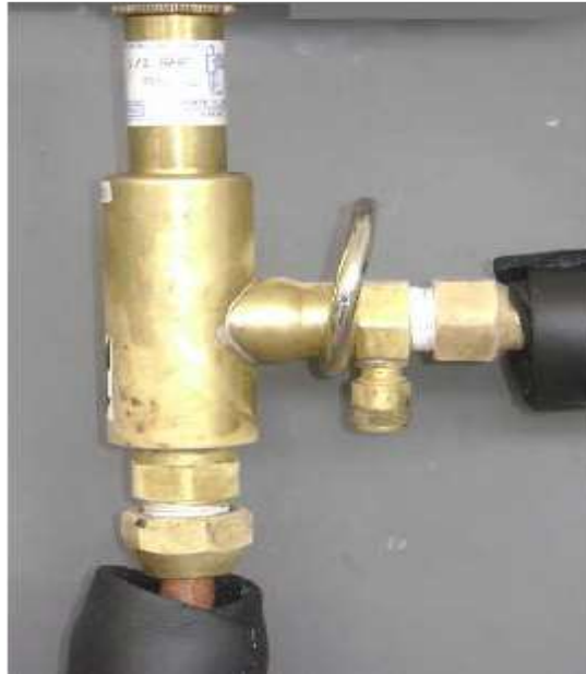
Figura 50. Instalación de la válvula reguladora de presión
