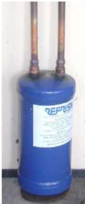
Figura 52. Instalación de acumulador de succión
