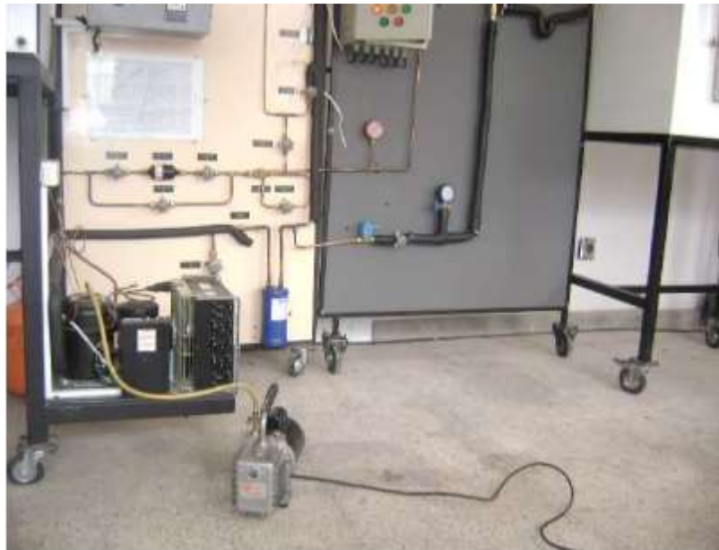
Figura 59. Proceso de vacío
