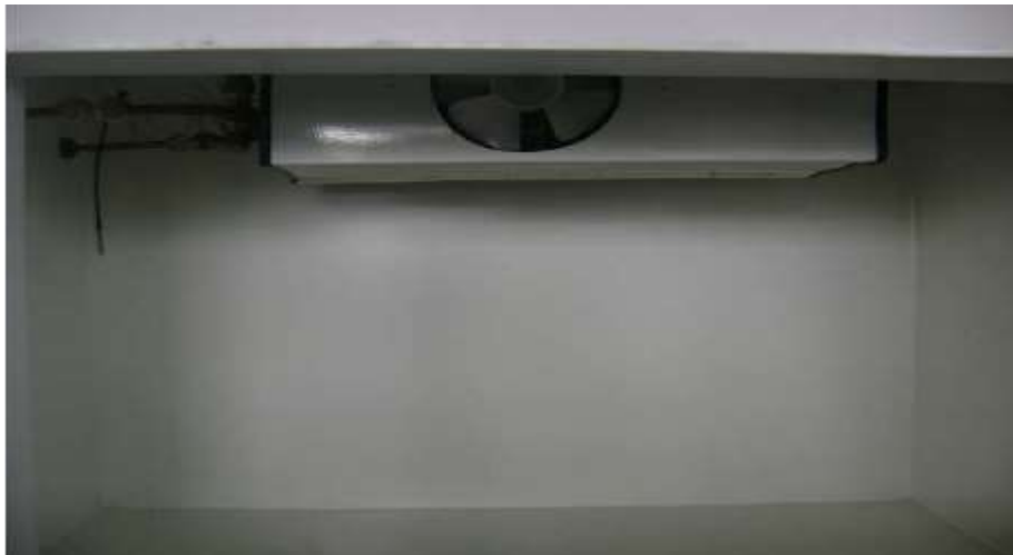
Figura 46. Ubicación del evaporador de aire forzado
