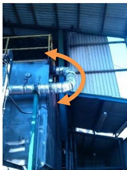
Figura 61. Primer segmento ensamblado de tubería aceite térmico
