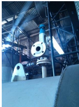
Figura 84. Válvula de seguridad de generador de vapor
