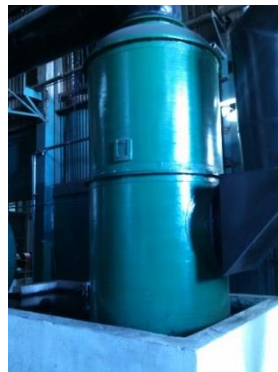
Figura 76. Separador ciclónico de ceniza
