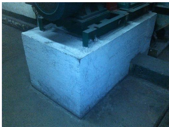
Figura 33. Base de motor de turbina de chimenea
