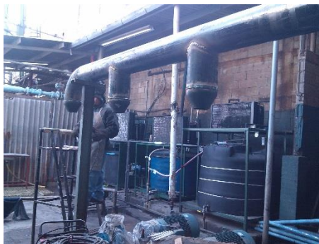
Figura 62. Soldadura de tubería
