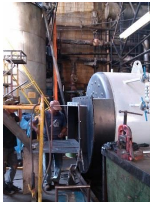
Figura 71. Fabricación de ductos
