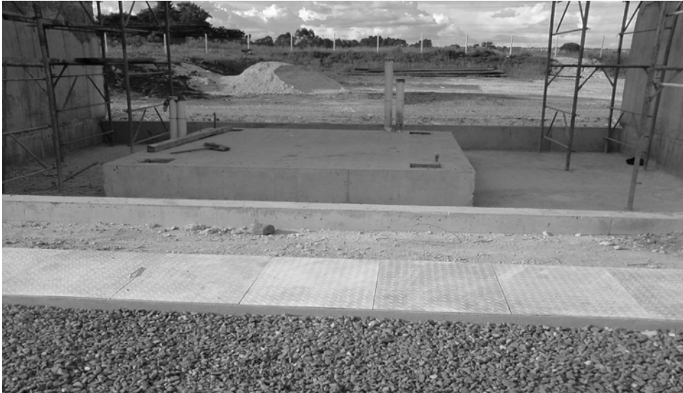
Figura 27. Tapa metálica de canaleta
