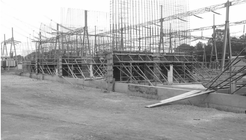
Figura 23. Levantamiento de muros 1
