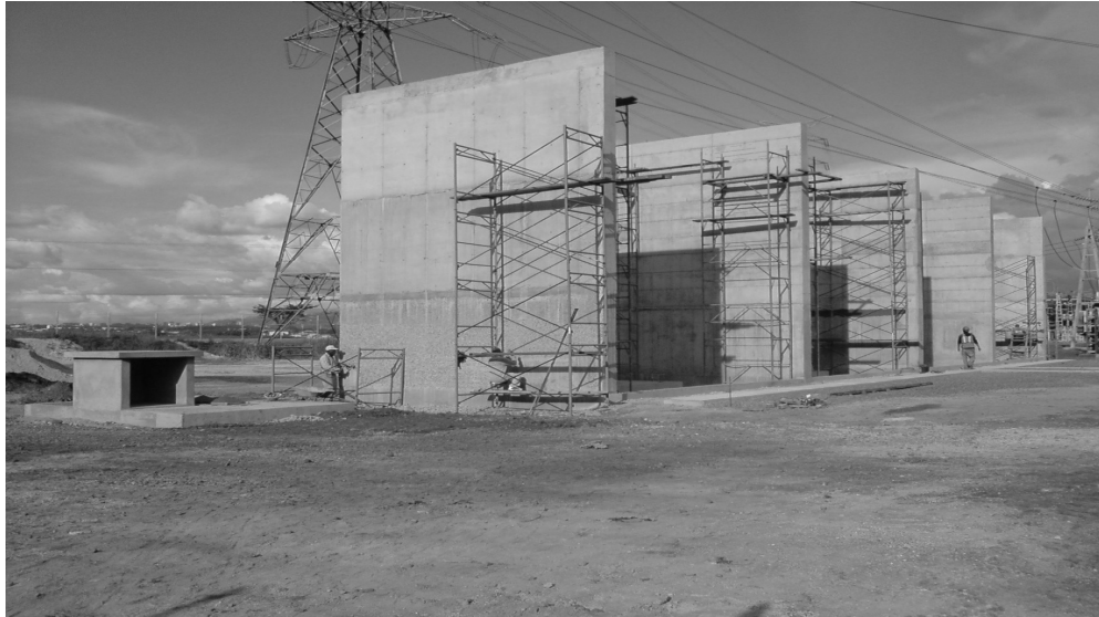
Figura 25. Muros cortafuegos
