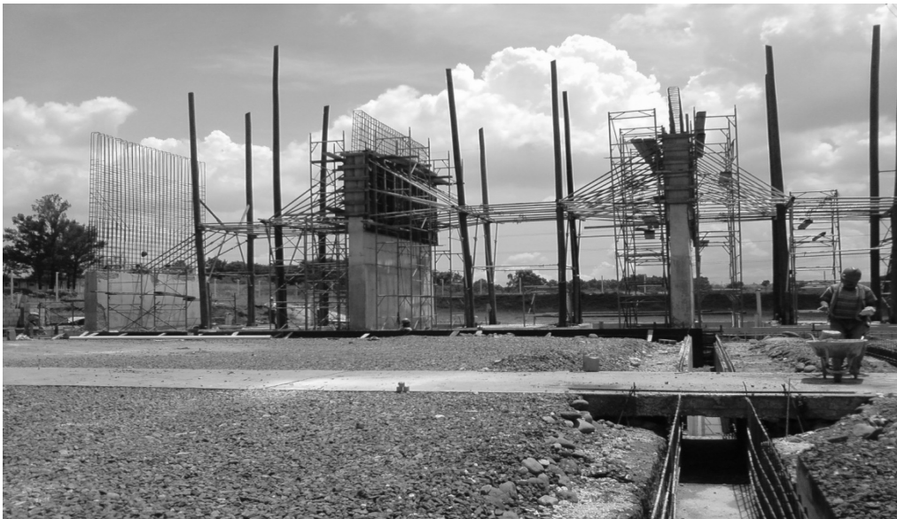
Figura 24. Levantamiento de muros 2
