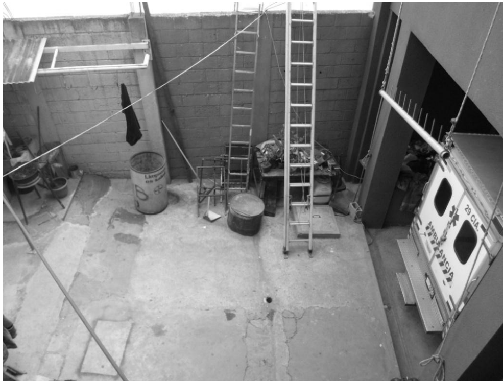
Figura 27. Lugar de instalación del chiller enfriado por aire
