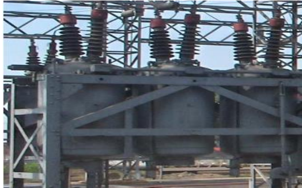
Figura 8. Interruptor de gran volumen de aceite
