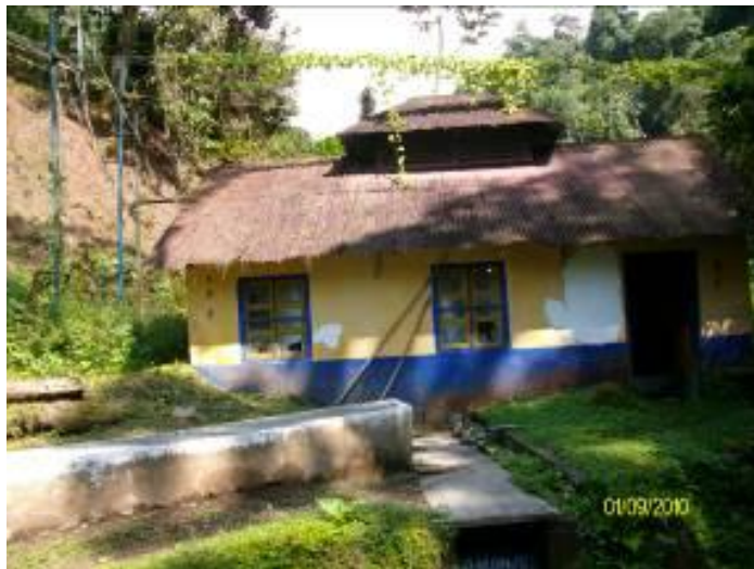
Fotografía No. 10 Casa de Máquinas
