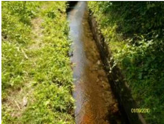
Fotografía No. 2 Canal del tipo abierto de cemento
