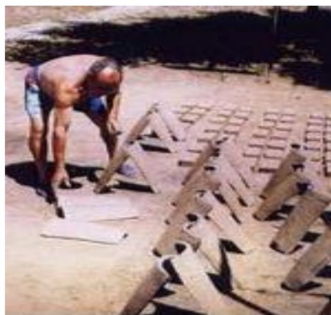
Figura 19. Colocación de las tejas en parejas
