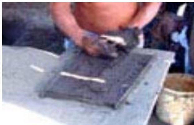
Figura 14. Llenado de gradilla (paso 2)
