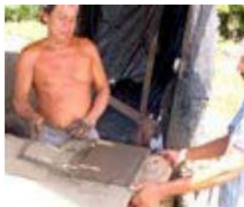
Figura 16. Colocación de la teja en el galápago
