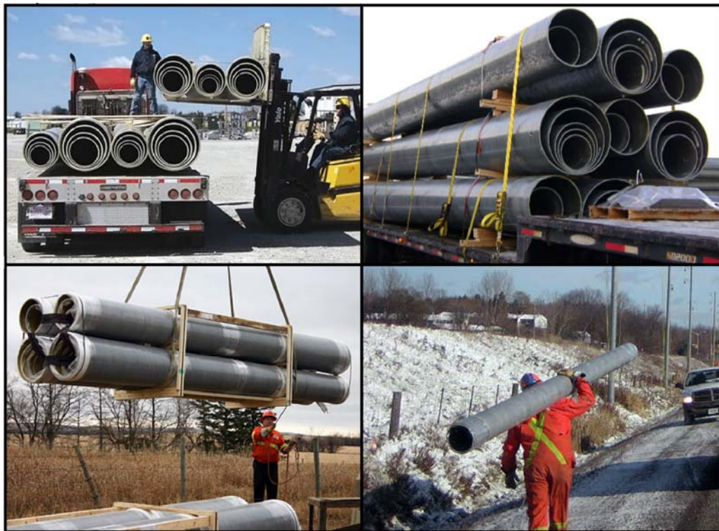
Figura 40. Movilización e instalación
