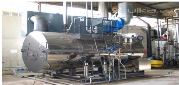
Figura 12. Instalación de una caldera
