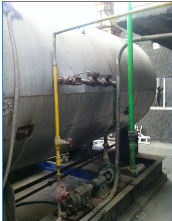
Figura 85. Trampeo en cabezales de vapor caldera Power Master
