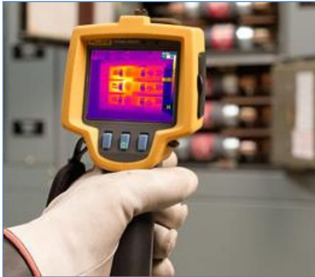
Figura 68. Diagnóstico de fallas por medio de la cámara termográfica
